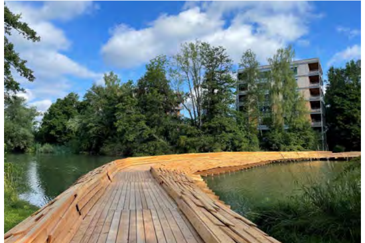
Kawamatabrücke im Zellwegerpark, die soeben saniert wurde, Blick Richtung Nord
