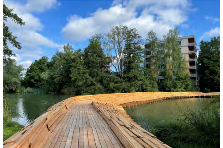
Le pont de Kawamata dans le parc Zellweger, récemment rénové, vue vers le nord
